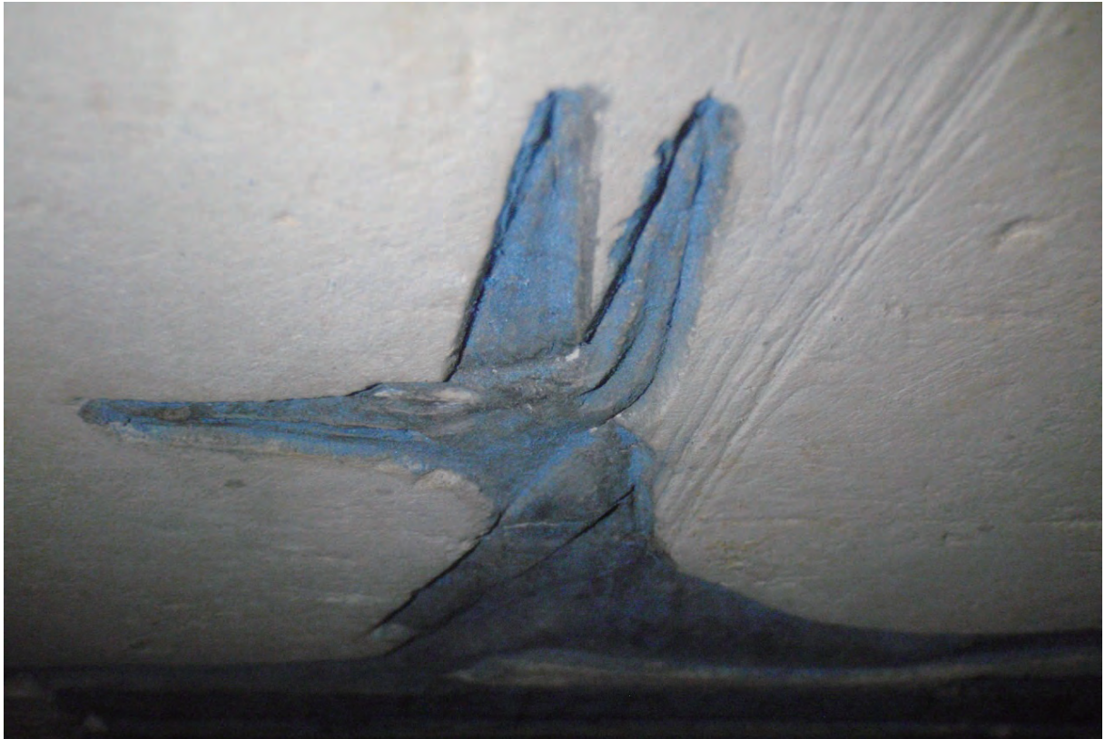
Fig.35 石棺身南面強化処置後 (2)
